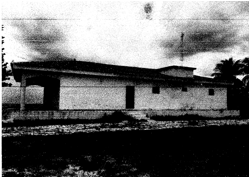
FOTO 04 – Fachada Lateral Interna onde Funciona o CRAS
