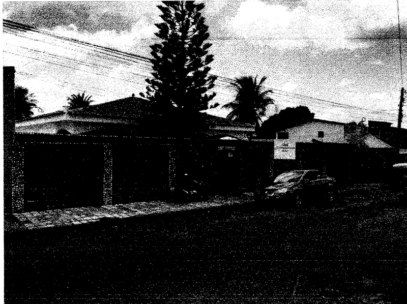
FOTO 01 – Fachada Frontal Externa
