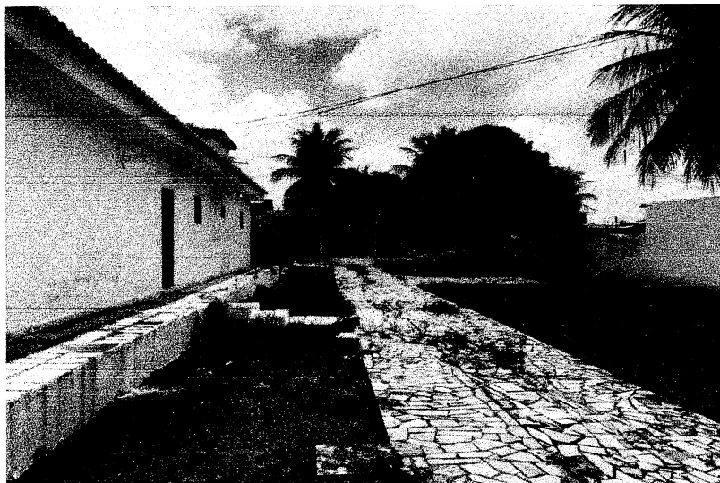
FOTO 05 – Lateral externa da edificação, terreno livre
